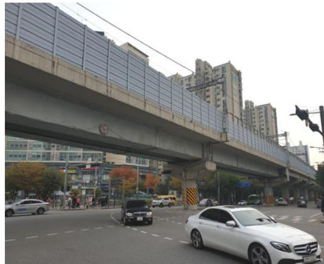
Steel Box 구간
