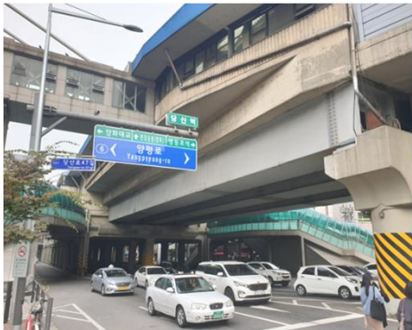
Steel Box 구간
