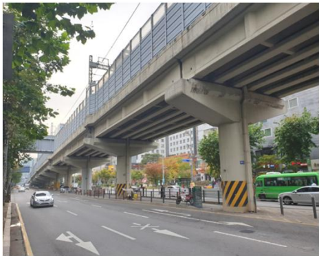
PSC Beam 구간
