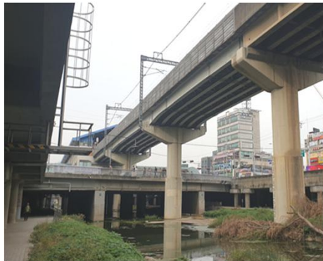
Steel Plate 구간
