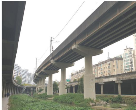
PSC Beam 구간
