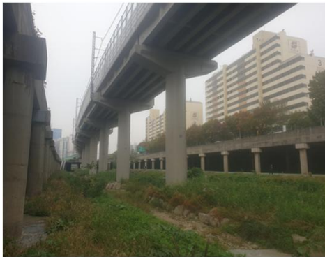
PSC Beam 구간
