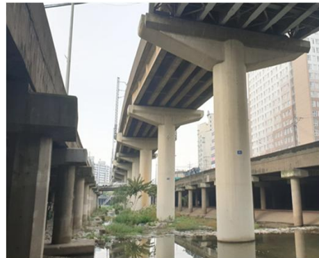
PSC Beam 구간
