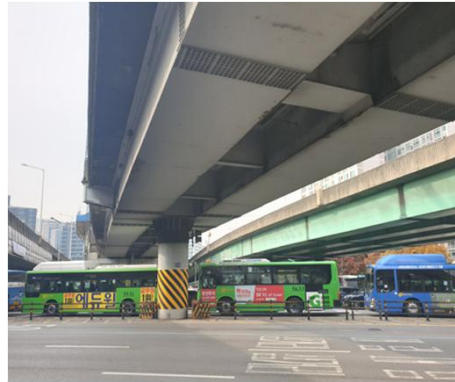
Steel Box 구간
