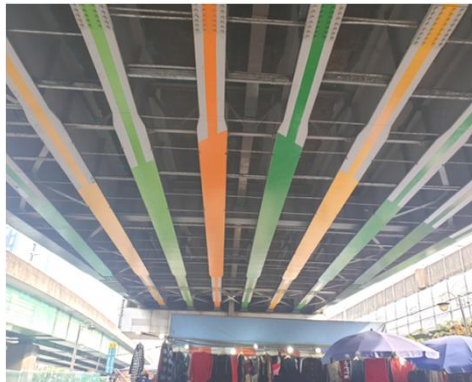
Steel Plate 구간
