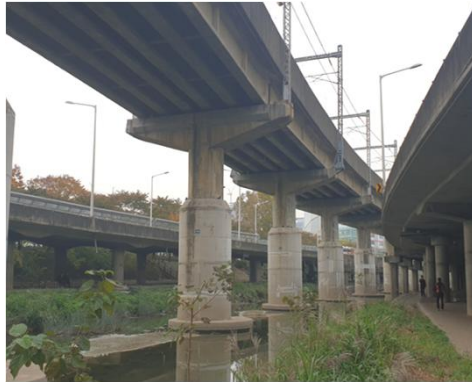
PSC Beam 구간
