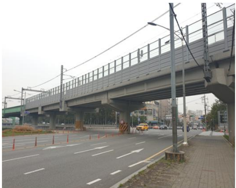
PSC Beam 구간
