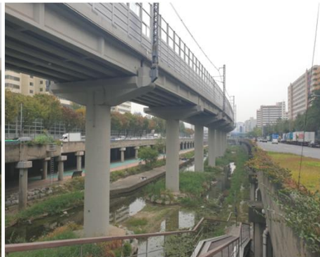
PSC Beam 구간
