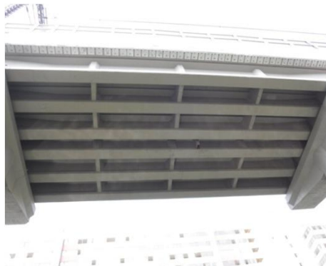
PSC Beam 구간
